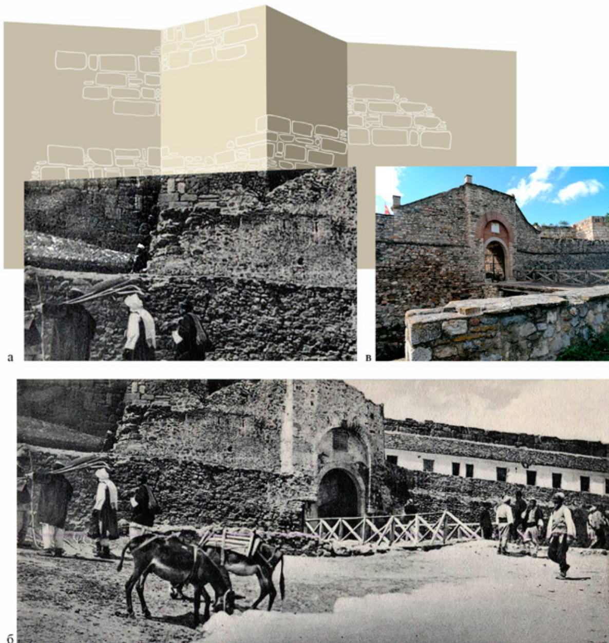
Сл. 17. Делот на „киклопскиот бедем“ од скопскиот „Горни Град“ зад источната порта: а, б. фотографија - Скопје 2020; цртеж (шешатска реконструкција) – Никос Чаусидис; в. фотографија – Никос Чаусидис
