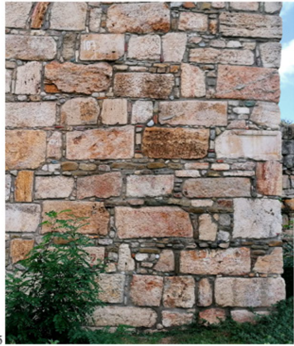
Сл. 8. Споредба на опусите на сидање (според А. Еванс): а. Хосиос Лукас во Стيري, X век (Hosios Loukas 2020); б. Четириаголна кула на „киклопскиот бедем“ од скопскиот „Горни Град“ (фотографија – Никос Чаусидис)
